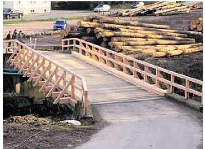
*Die sanierte Fenschenrainbrücke mit neuem Boden und neuem Geländer.*
