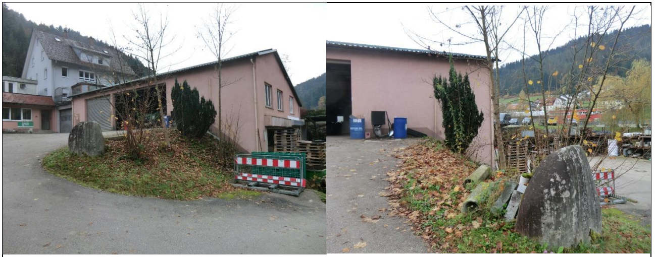
Abb. 3: Gebäude Firma Läufer mit kleiner Grünfläche
