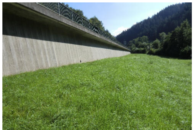
Abb. 6 Mauer zur Bundesstraße, Standort für vorgesehenen Parkplatz
