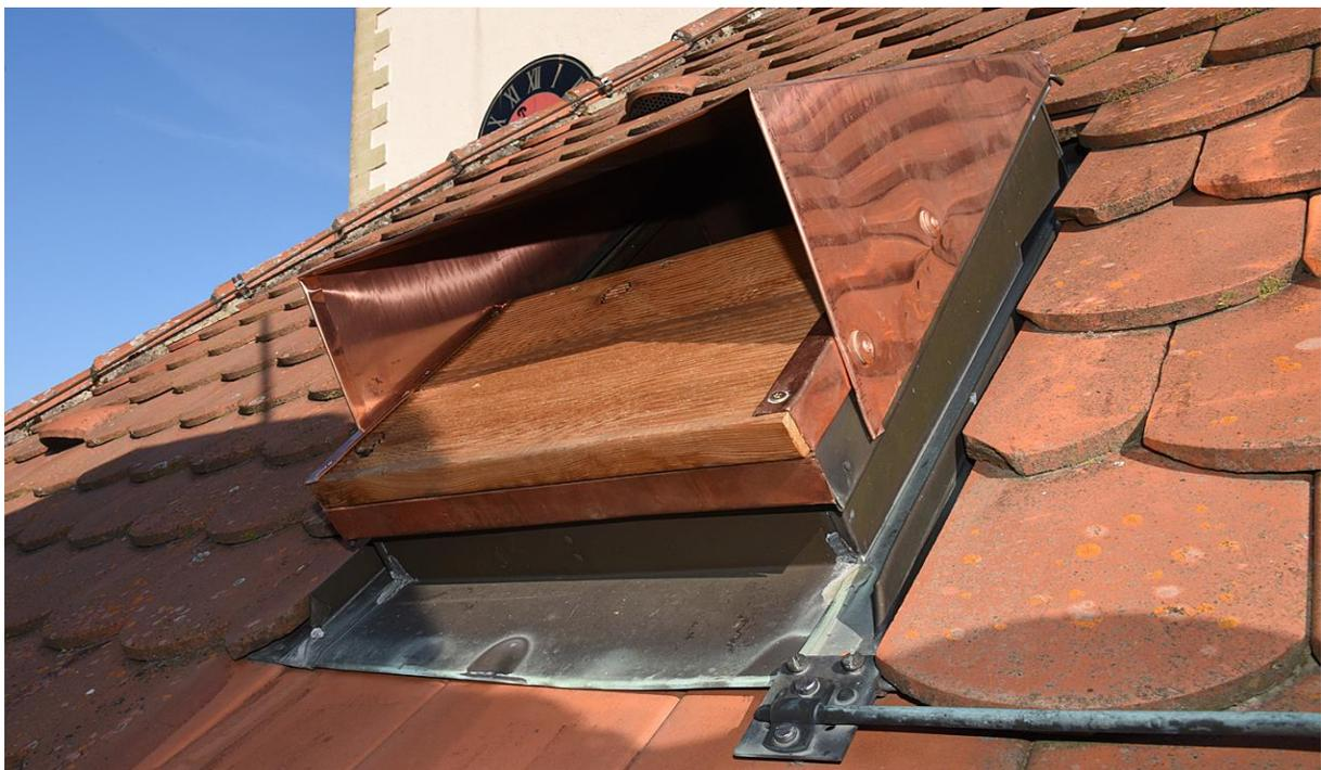
**Abbildung 25:** Außenansicht eines umgebauten Dachflächenfensters. Foto: C. Dietz.
