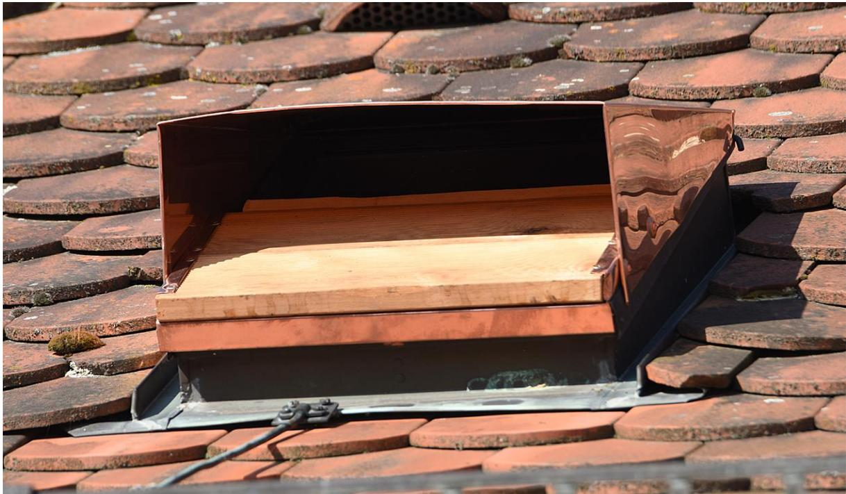
**Abbildung 24:** Außenansicht eines umgebauten Dachflächenfensters. Foto: C. Dietz.
