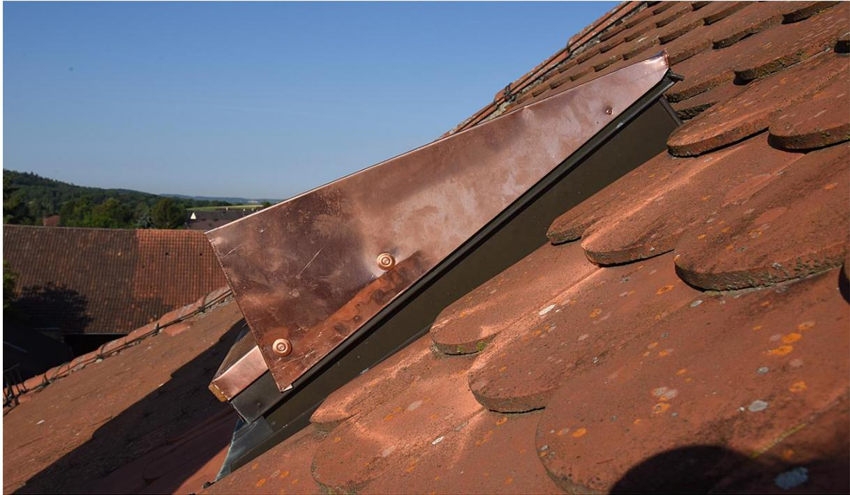
**Abbildung 26:** Außenansicht eines umgebauten Dachflächenfensters. Foto: C. Dietz.
