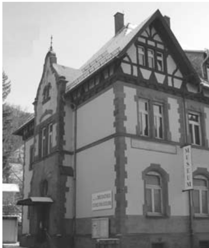
Das Bild zeigt das Gebäude, in dem das Stadtmuseum Hornberg untergebracht ist. Es ist das im Jahre 1902 gebaute damalige Großherzoglich Badische Finanz- und Zollamt Hornberg.
